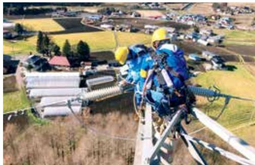
雷による送電線事故を防止する装置の設置作業
