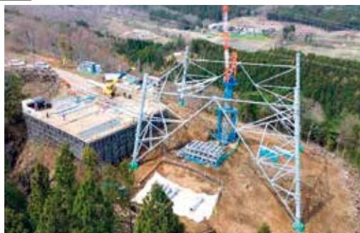
50万ボルト送電線の新設工事
