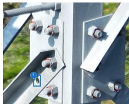
ボルト脱落穴の検出
