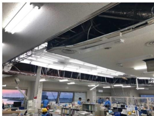
事務本館5階 執務室
