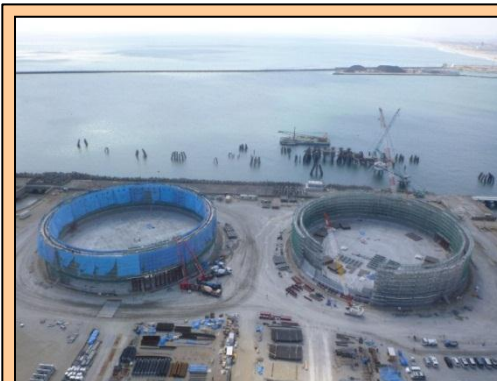
Shin-Sendai Thermal No.3 series Construction of LNG tank
