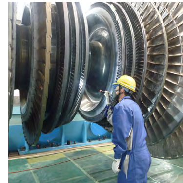
蒸気タービン動翼点検の様子
