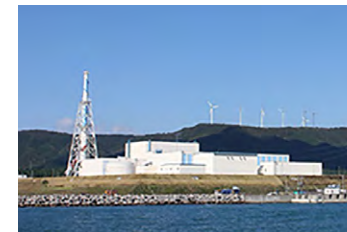
東通原子力発電所(青森県)
