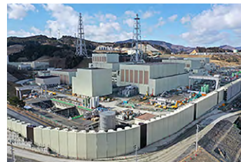
女川原子力発電所(宮城県)
