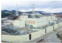
防潮堤かさ上げ工事
