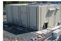
緊急時対策所
