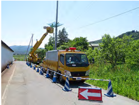
工事範囲のバリケード設置
