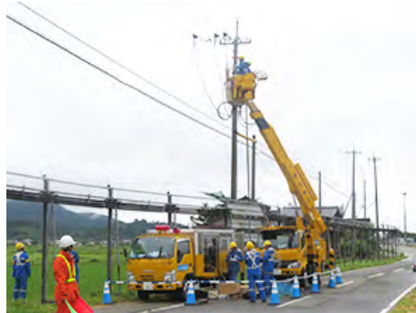
交通誘導員の配置
