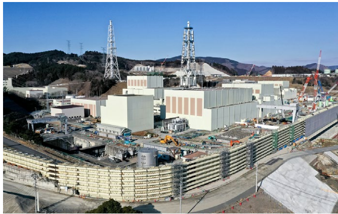
防潮堤(写真手前)の工事が進捗している(女川原子力発電所)
