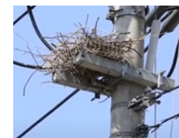
営巣箱の設置による対策
