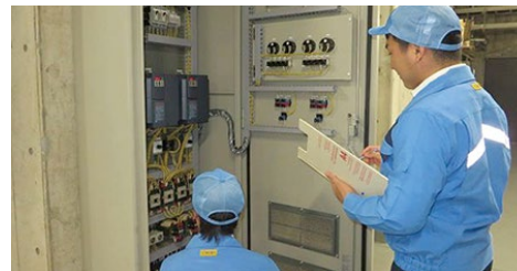
お客さま設備調査の様子
