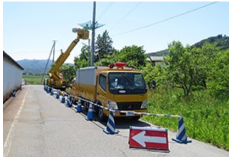
工事範囲のバリケード設置
