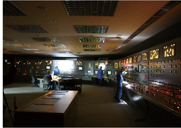
交流電源が全て使えなくなる事故を想定したシミュレーター装置による運転訓練(原子力技術訓練センター)
