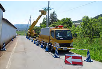
工事範囲のバリケード設置
