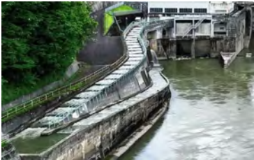
魚道（上郷発電所）
