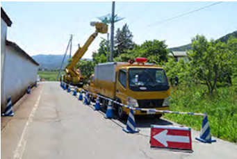
工事範囲のバリケード設置
