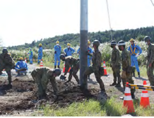
道路寸断を想定した復旧作業訓練 【陸上自衛隊】
