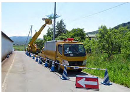
工事範囲のバリケード設置
