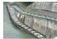
ダムに設置されている魚道
