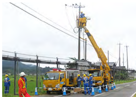
交通誘導員の配置
