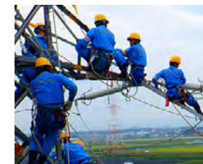
送電部門における電線付属品付け訓練の様子
