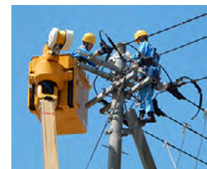
配電部門における技能訓練の様子
