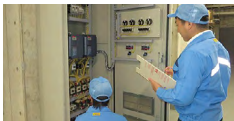
お客さま設備調査の様子
