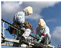
原子力災害発生時を想定し、防護服を着用した状態で原子力外部電源事故の復旧を模擬した訓練を実施することにより、想定される状況における原子力外部電源復旧作業の習熟を図っています。
