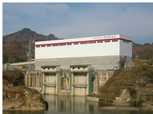
鹿瀬発電所(新潟県東蒲原郡阿賀町)
