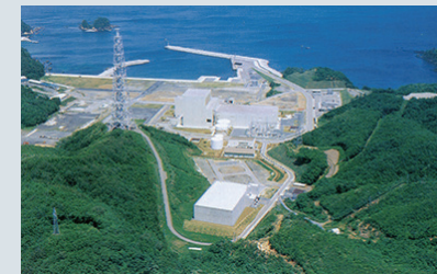
運転開始当時の女川原子力発電所
