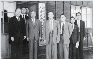
八戸火力発電所建設所にて
