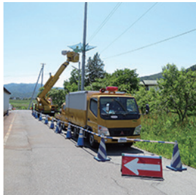
工事範囲のバリケード設置
