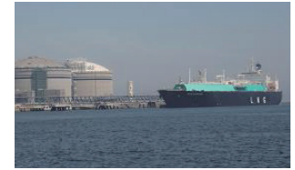
新仙台火力発電所に入港する プテリ・ムティアラ・サツ号(マレーシア)
