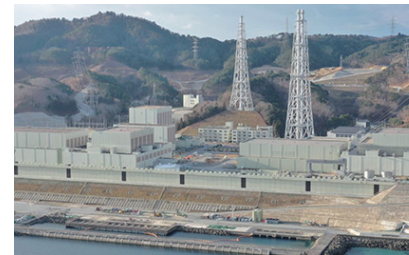
安全対策工事が進む女川原子力発電所
