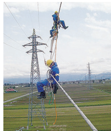
送電線点検作業
