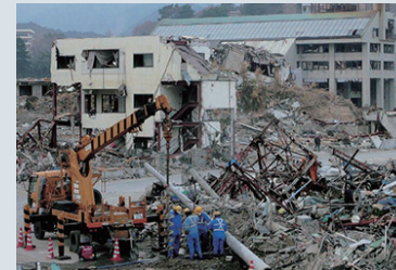
震災直後の建柱作業の様子
