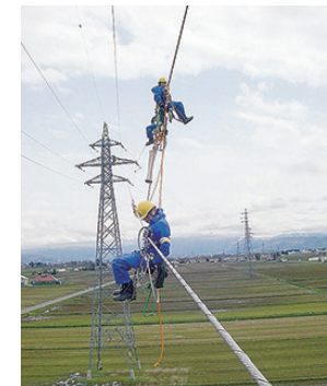
送電線点検作業
