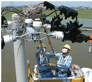
停電の未然防止に向けたカラスの巣の撤去作業
