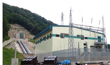
新設した玉川第二発電所（2022年11月竣工）
