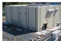
緊急時対策所
