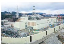
防潮堤かさ上げ工事
