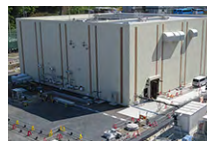
緊急時対策所
