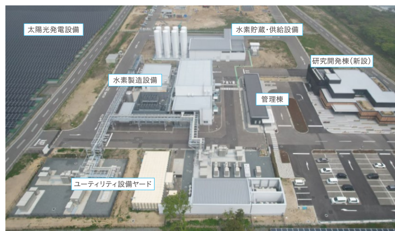
完成した福島水素エネルギー研究フィールド(FH2R)
