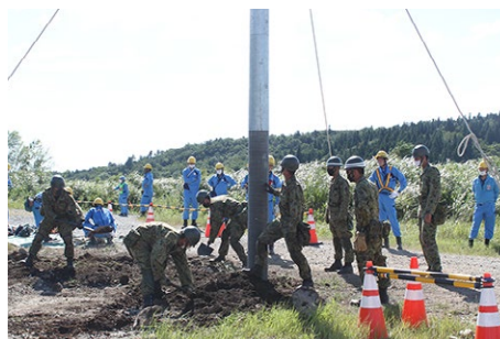
道路寸断を想定した復旧作業訓練【陸上自衛隊】
