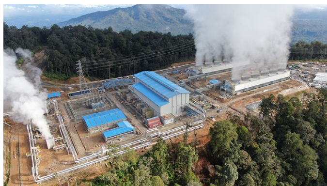
ランタウ・デダップ地熱発電所(インドネシア)
