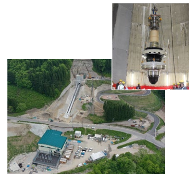
玉川第二発電所建設工事
