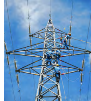
送電部門における送電線接地付け外し教育訓練の様子
