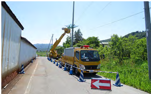
工事範囲のバリケード設置
