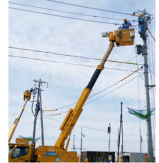
配電部門における技能訓練の様子
