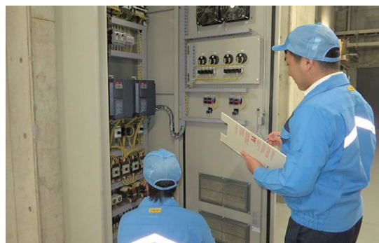
お客さま設備調査の様子
