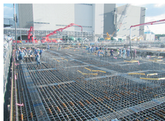
能代火力発電所3号機基礎工事でのコンクリート大量打設の状況
