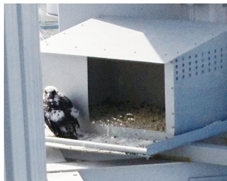
煙突の人工巣で確認されたハヤブサの雛(新仙台火力発電所)
