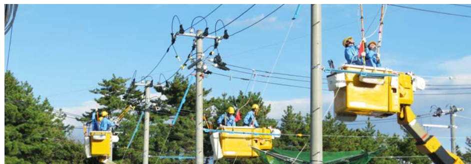
穴掘建柱車による建柱訓練の様子(配電)
