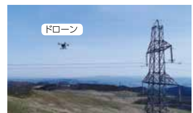
ドローンを活用した架空送電線の点検状況（試験）
