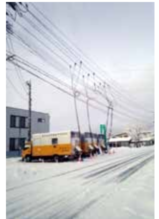
着雪により変形した鉄塔の復旧作業ならびに高圧応急電源車による供給力確保 (2017年12月山形県内)
