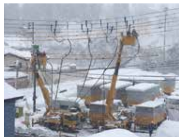
応急高圧電源車による送電の様子
