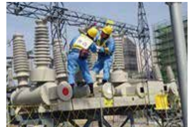
総合技能大会の様子（変電）
