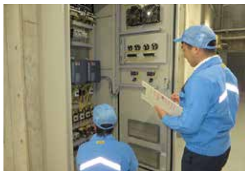
お客さま設備調査の様子
