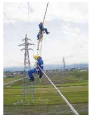
送電線点検作業
