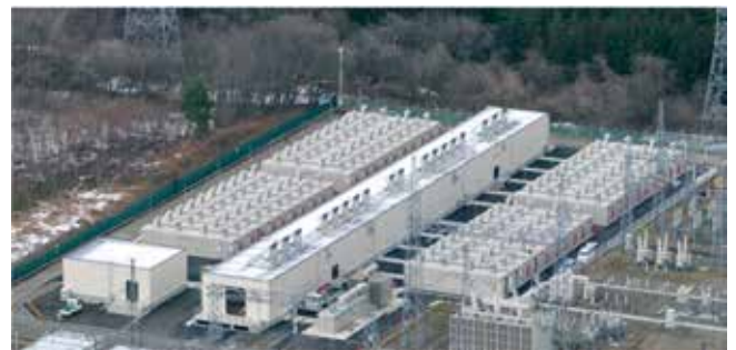
西仙台変電所 蓄電池システム (リチウムイオン電池)
