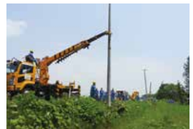
穴掘建柱車による建柱訓練の様子（配電）
