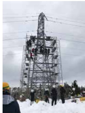
着雪により変形した鉄塔の復旧作業ならびに高圧応急電源車による供給力確保 (2017年12月山形県内)
