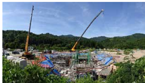
玉川第二発電所建設の様子
