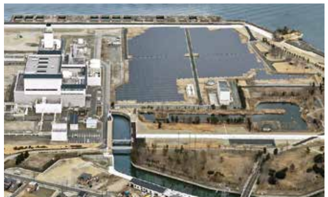
《仙台太陽光発電所》
