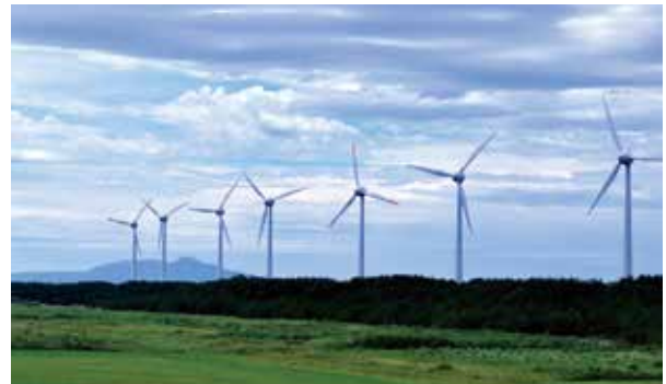
能代風力発電所
