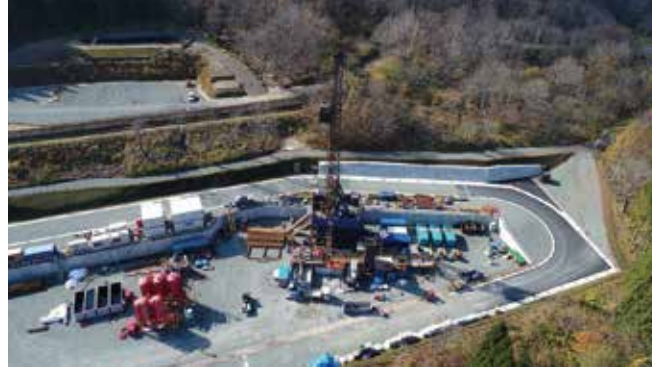
《大口径調査井掘削状況》
