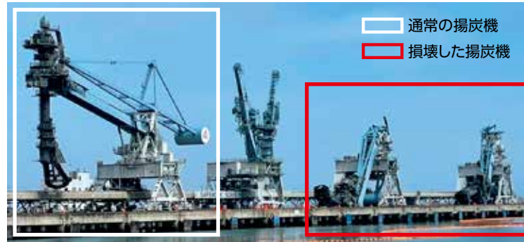
地震により揚炭機が損壊した相馬共同火力発電(株)新地発電所
