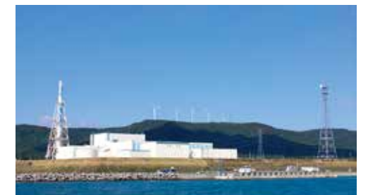
東通原子力発電所
