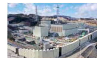
安全対策工事が進む女川原子力発電所
