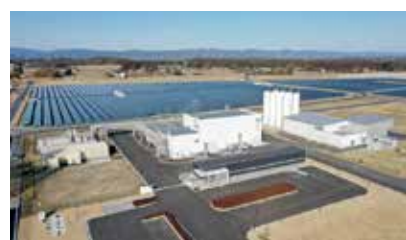
福島水素エネルギー研究フィールド
