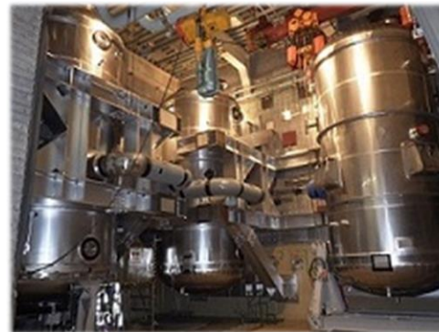
フィルタベント系設置工事
