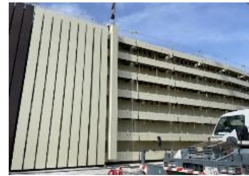
防潮堤かさ上げ工事
