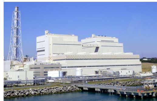
原町火力発電所
