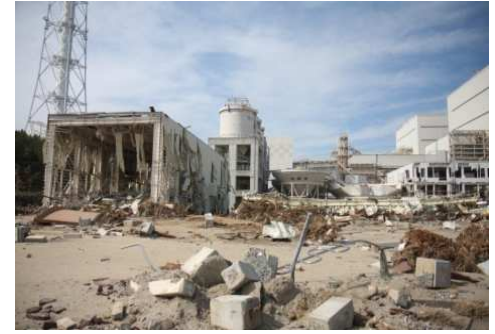
[原町火力発電所]
