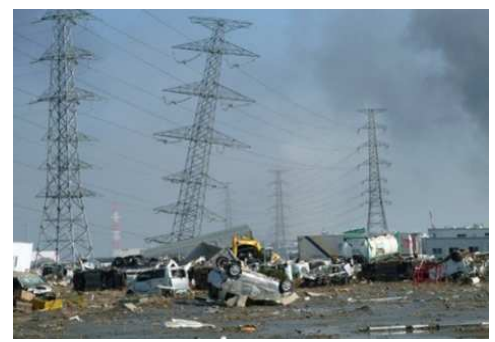
[傾斜した鉄塔(宮城県多賀城市)]
