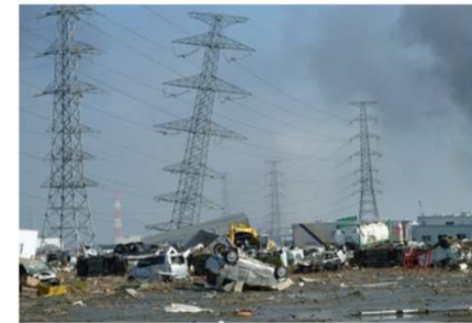
【傾斜した鉄塔(宮城県多賀城市)】
