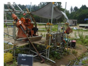
ボーリング調査の例
