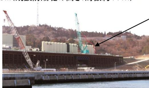
建込み中の鋼管杭(上杭部分)
