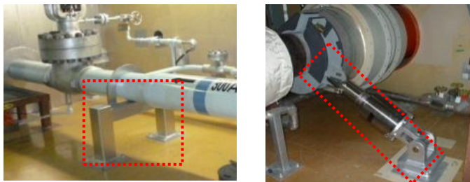
耐震工事の実施状況
