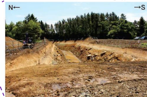
掘削状況 (Tr-30トレンチ)
