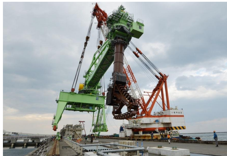
②揚炭機設置(2012年10月)
