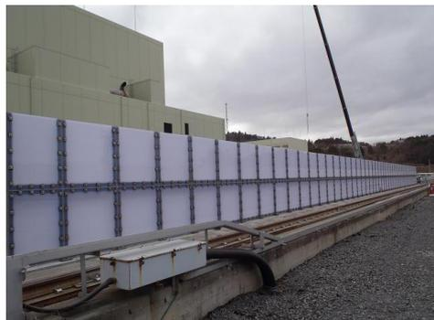
原子炉建屋内に滞留した水素を迅速・確実に放出するための原子炉建屋ベント装置(東通)
