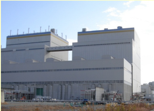
ボイラータービン建屋全景
