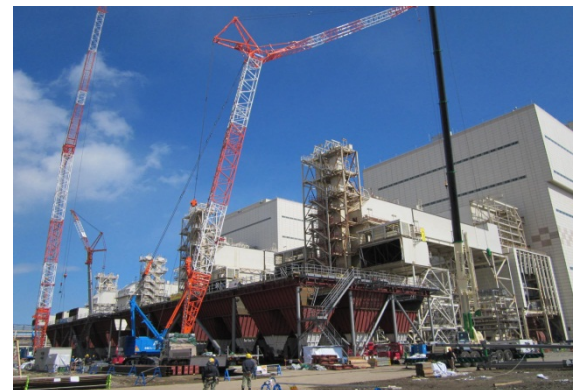
1号機 電気集塵器復旧状況
