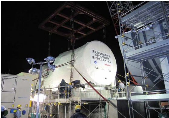
八戸火力発電所 5号機 (2012年3月)
