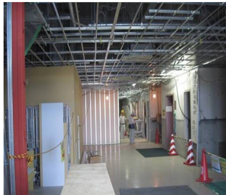
タービン建屋1F入口
