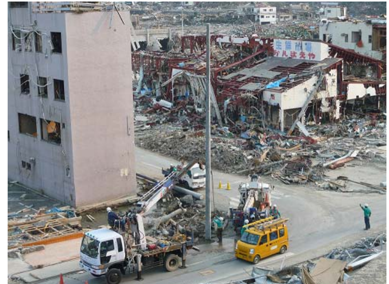
(宮城県 牡鹿郡 女川町での復旧作業)
