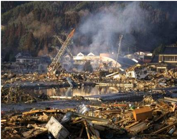
送電設備〔鉄塔〕 (岩手県 上閉伊郡 大槌町)
