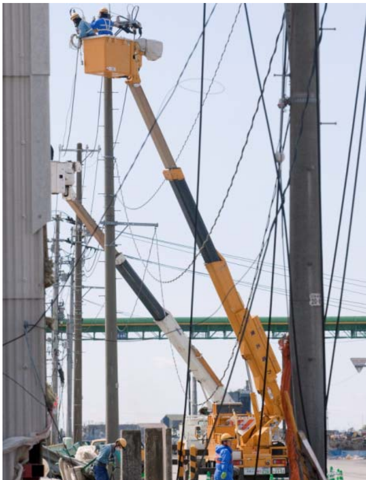
(宮城県 牡鹿郡 女川町での復旧作業)
