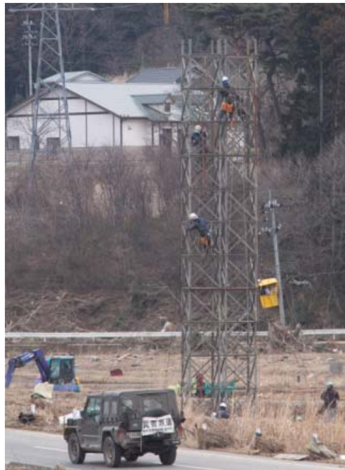
(宮城県 気仙沼市での復旧作業)
