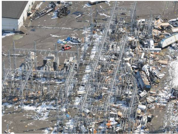
多賀城変電所 (宮城県 仙台市)
