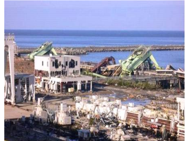
原町火力発電所 (福島県 南相馬市)
