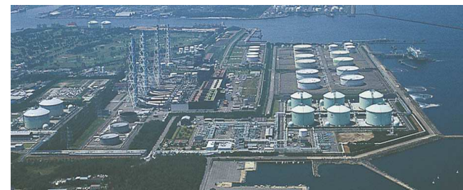
【写真は当社東新潟火力発電所と日本海LNG新潟基地】
