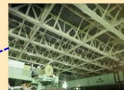
オベーションフロアの天井(左)・壁面(右)の耐震補強
