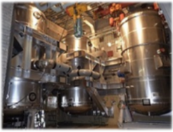
女川原子力発電所 原子炉格納容器フィルタベント系
