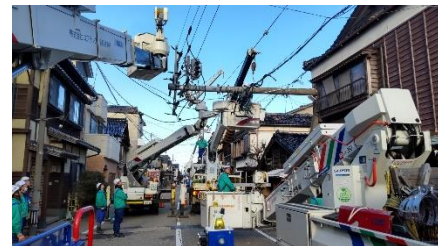
折損した電柱の改修
