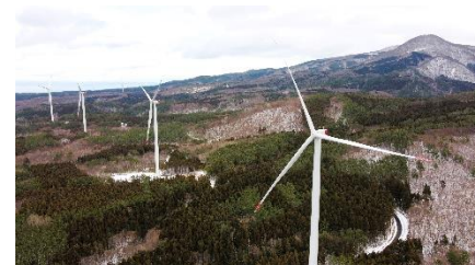
【グリーンパワー-深浦風力】 青森県深浦町 出力73,600kW (2024年2月 営業運転開始) (写真提供:株式会社グリーンパワーインベストメント)
