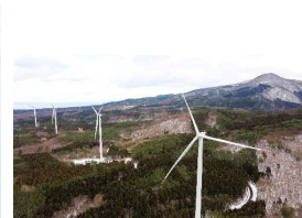
【グリーンパワー深浦風力】 青森県深浦町 出力73,600kW (2024年2月 営業運転開始) (写真提供:株式会社グリーンパワー・イノベーション)
