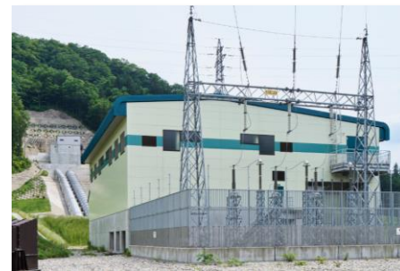
【玉川第二発電所(水力)】 山形県小国町 出力14,600kW (2022年11月 営業運転開始)
