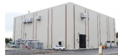
女川原子力発電所 緊急時対策建屋
