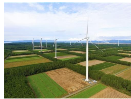
【ウインドファームつがる】 青森県つがる市 出力121,600kW (2020年4月 営業運転開始) (写真提供:株式会社グリーンパワーインベストメント)
