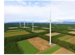
【ウィンドファームつがる】 青森県つがる市 出力121,600kW (2020年4月 営業運転開始) (写真提供:株式会社グリーンパワーワイヴストマト)
