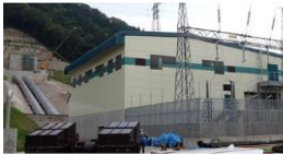
【玉川第二発電所(水力)】 山形県小国町 出力14,600kW (2022年11月 営業運転開始)
