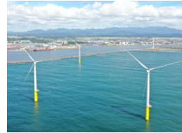
【秋田港・能代港洋上風力発電所】 秋田県秋田市、能代市 出力 計138,600kW (2023年1月 全面営業運転開始) (写真提供:秋田洋上風力発電株式会社)
