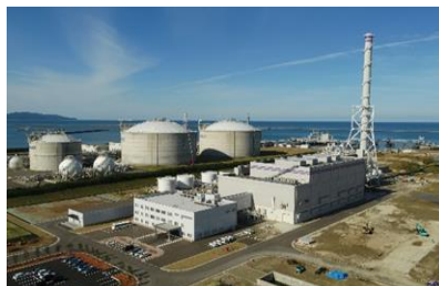
上越火力発電所 全景
