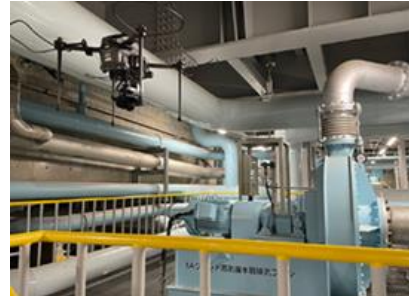
ドローンを活用した設備点検
