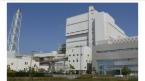
原町火力発電所1号機の復旧 (5月)
