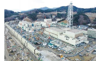
女川原子力発電所の工事状況
