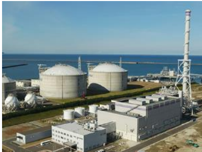
上越火力発電所全景
