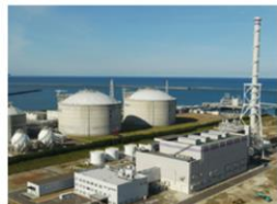
上越火力発電所全景
