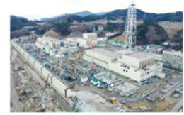
女川原子力発電所の工事状況
