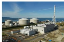
上越火力発電所 全景
