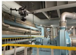
ドローンを活用した設備点検
