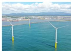
【秋田港・能代港洋上風力発電所】 秋田県秋田市、能代市 出力 計138,600kW (2023年1月31日 営業運転開始) 日本国内初の商業ベースでの 大型洋上風力発電プロジェクト (写真提供:秋田洋上風力発電株式会社)
