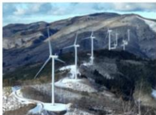
【JRE折爪岳南第一風力発電所】 岩手県二戸市、一戸町、九戸村 出力44,180kW (2023年1月14日 営業運転開始) 営業運転を開始した4件目の 陸上風力発電プロジェクト
