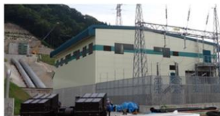
【玉川第二発電所（水力）】 山形県小国町 出力14,600kW (2022年11月7日 営業運転開始) グリーンファイナンスで調達した資金を 活用し建設
