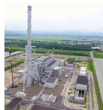
「上越1号・建設工事中」
