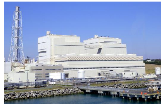
原町火力発電所
