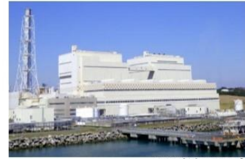
原町火力発電所
