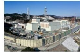
工事が進む高さ29mの女川原子力発電所の防潮堤
