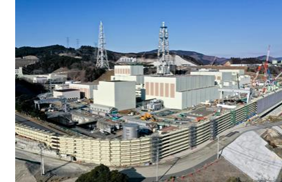
工事が進む海拔29mの女川原子力発電所の防潮堤
