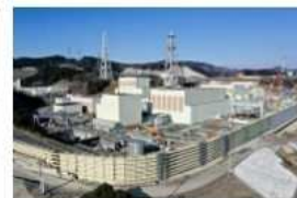
工事が進む海拔29mの女川原子力発電所の防潮堤
