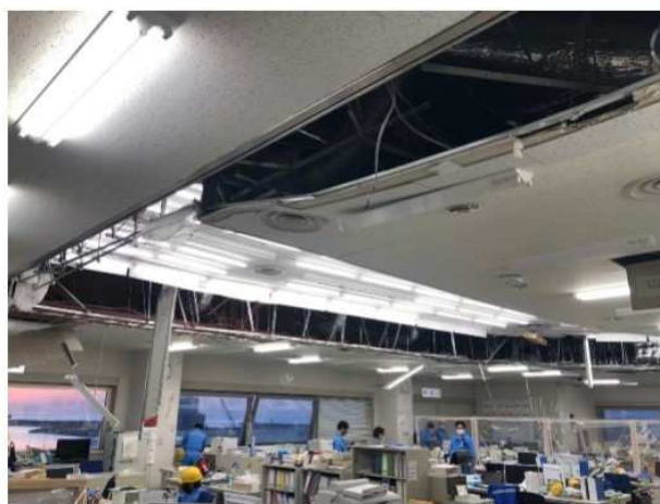
事務本館5階 執務室
