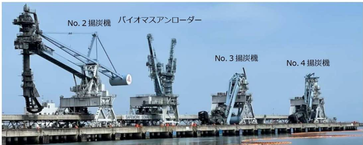
揚炭機は4基のうち、No.3、No.4揚炭機が損壊
