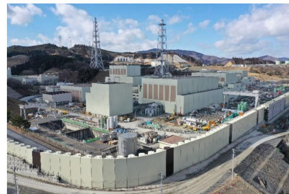
工事が進む海拔29mの防潮堤
