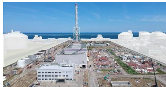
「上越1号・建設工事中」
